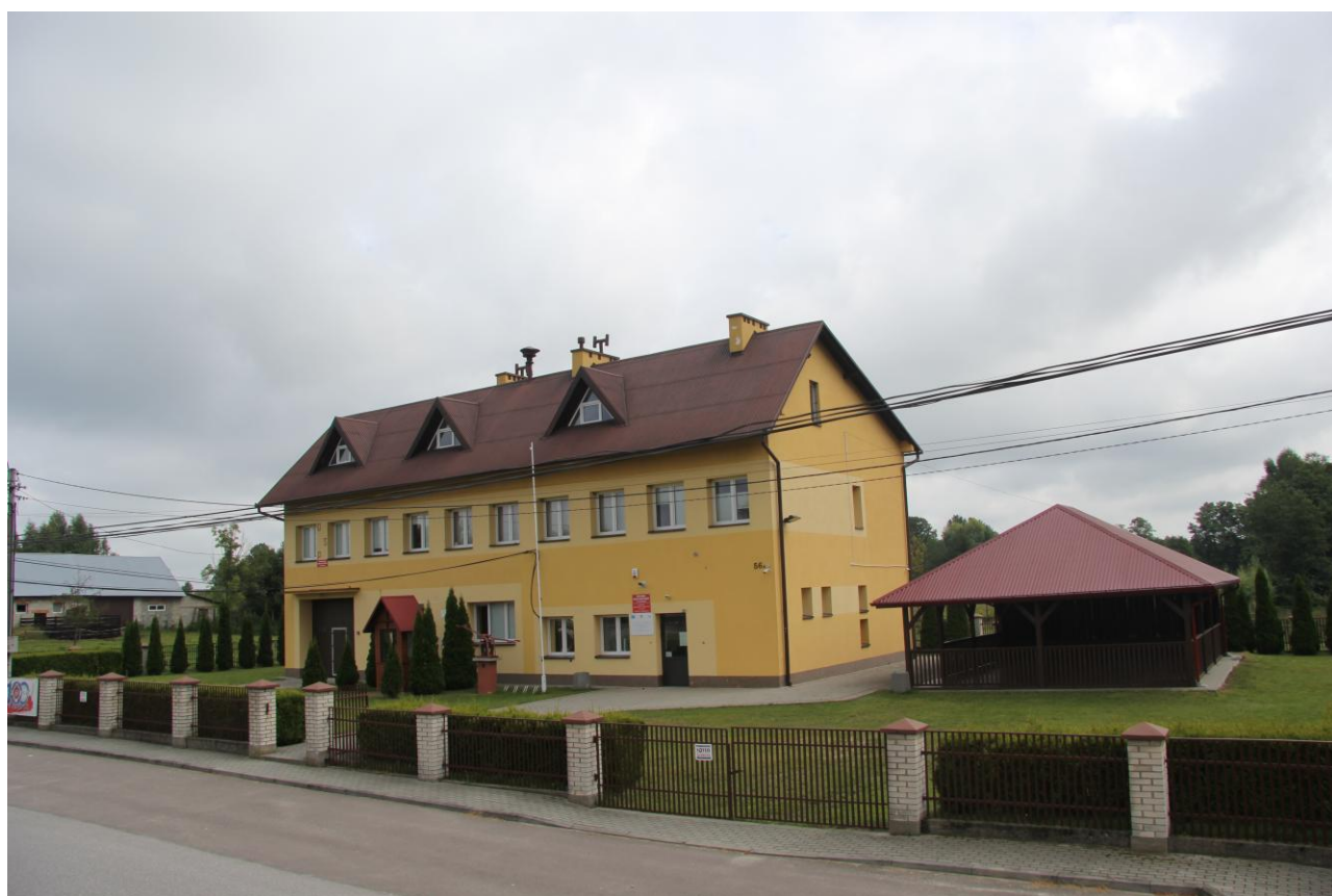
Wiejski Dom Kultury, OSP oraz drewniana wiata
