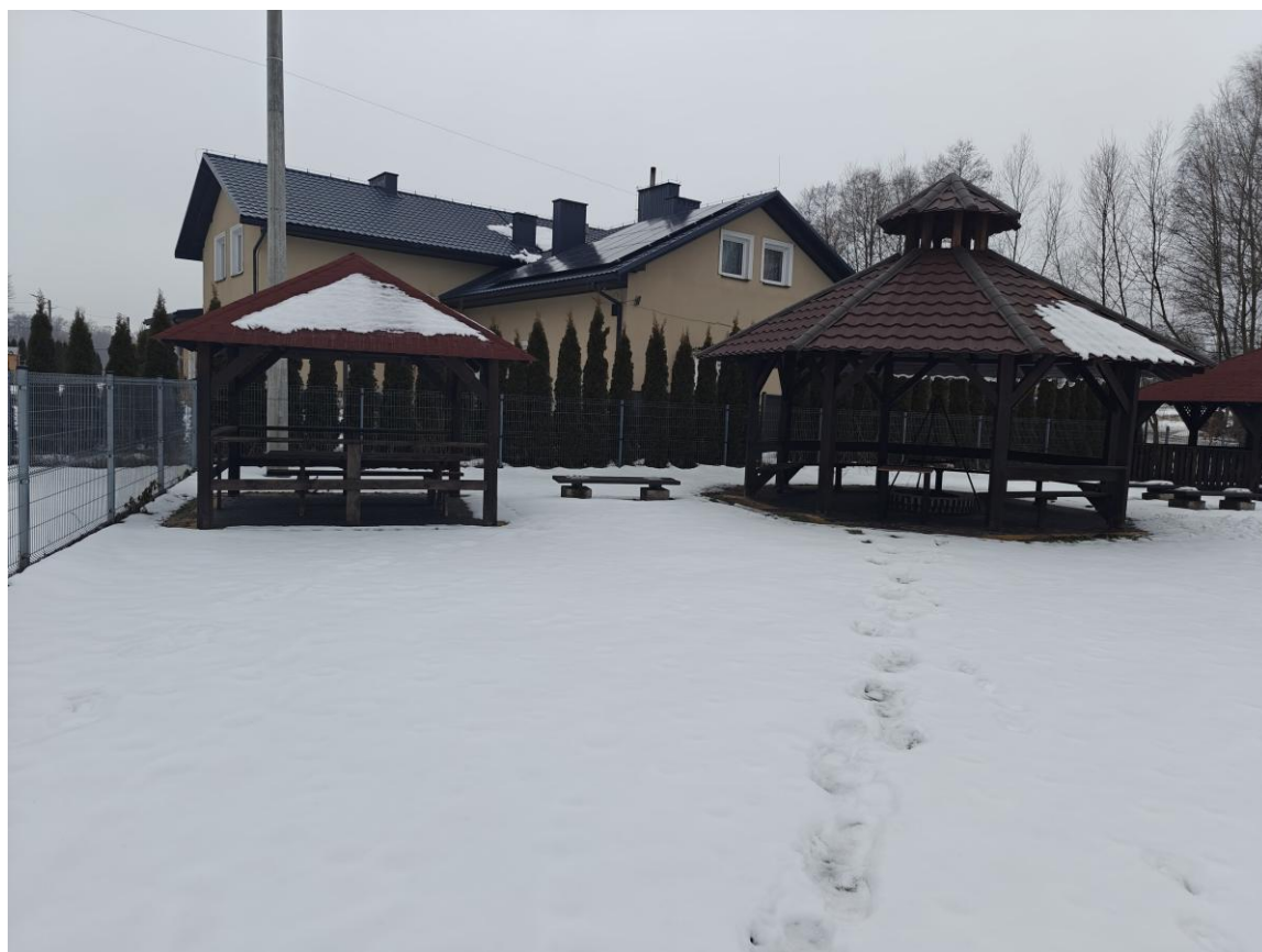
Drewniane wiaty na placu rekreacyjno-sportowym przy stadionie
